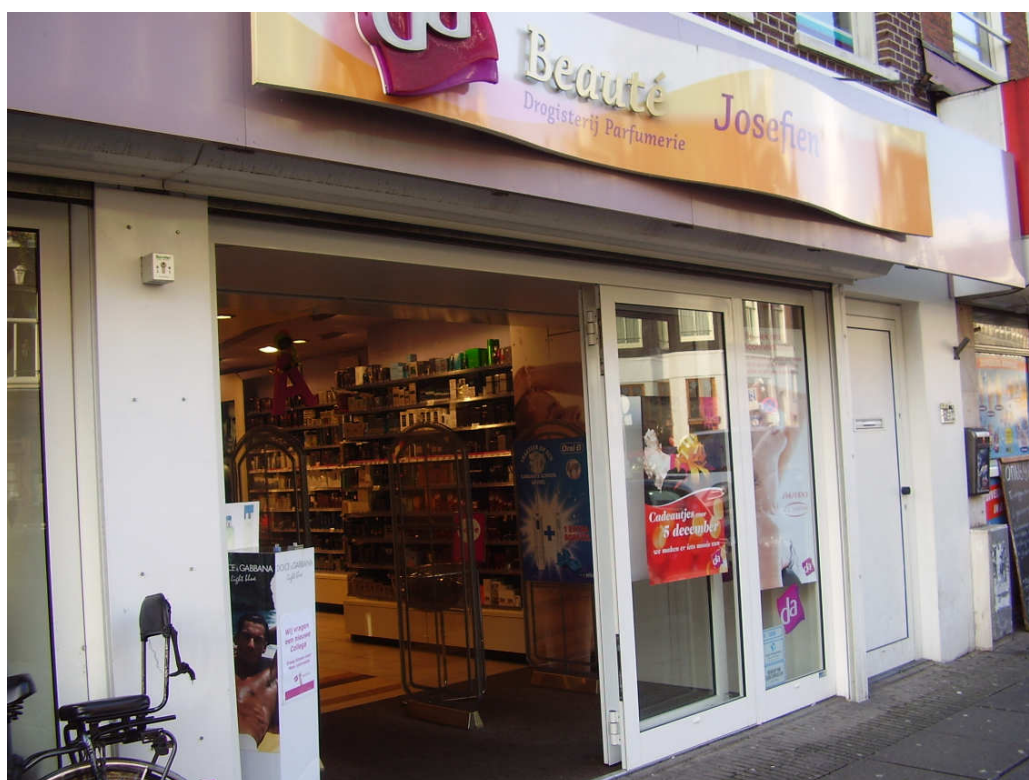
Figuur 1.1 Voorgevel DA drogist (oude deur)
